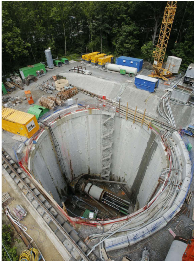
Der Abwasserkanal Emscher reicht bis in Tiefen von 40 m und hat in Teilabschnitten einen Durchmesser bis 2,80 m. Der Kanal wird vollständig aus Stahlbeton-Rohren bzw. in Tübbingbauweise im unterirdischen Vortrieb hergestellt.
