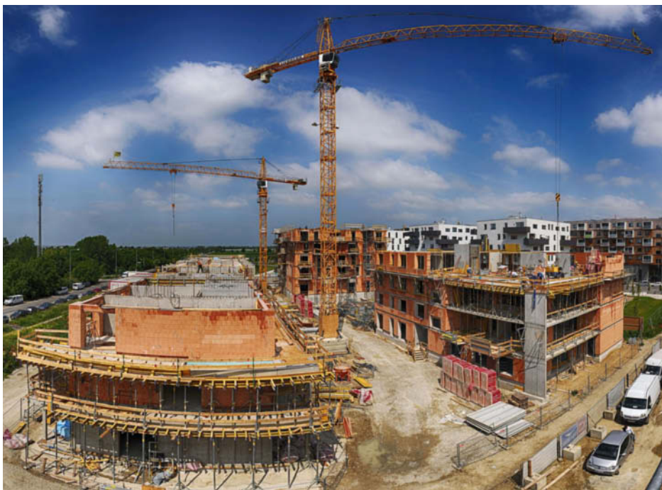
Die mehrgeschossigen Wohnbauprojekte auf Baufeld D22 und D23 in der Seestadt Aspern erhalten natürliche, energieeffiziente und wohngesunde Gebäudehüllen aus Ziegel.
